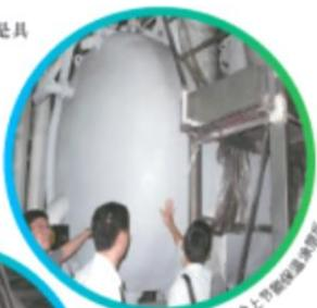
高温染色机表面喷涂工业隔热保温涂料
